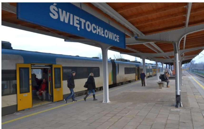
Rysunek 1 Peron na stacji kolejowej Świętochłowice – po remoncie
